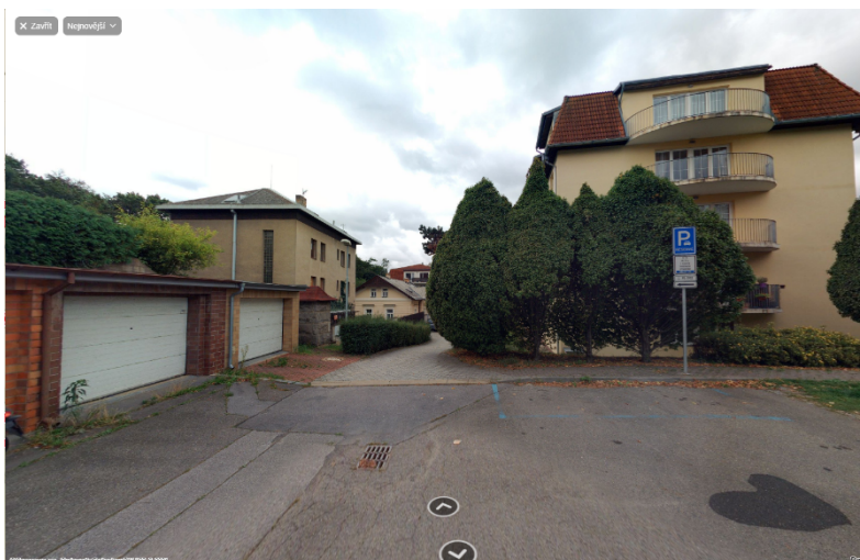
Obr.: Dopravní situace v místě umístění záměru – vjezd do budoucích garáží v místě stávajícího rodinného domu vlevo
